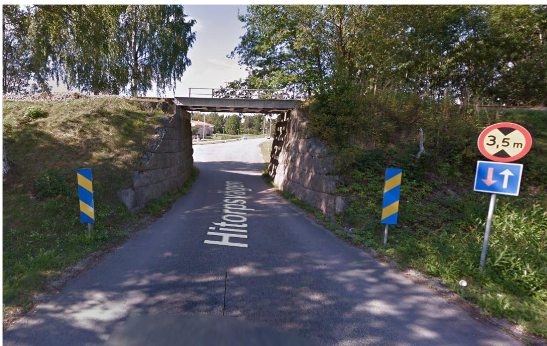
Figur 21: Befintlig järnvägsbro över Hitorpsvägen
