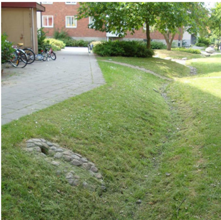
Figur 5: Svackdike med gräs. Sweco.
