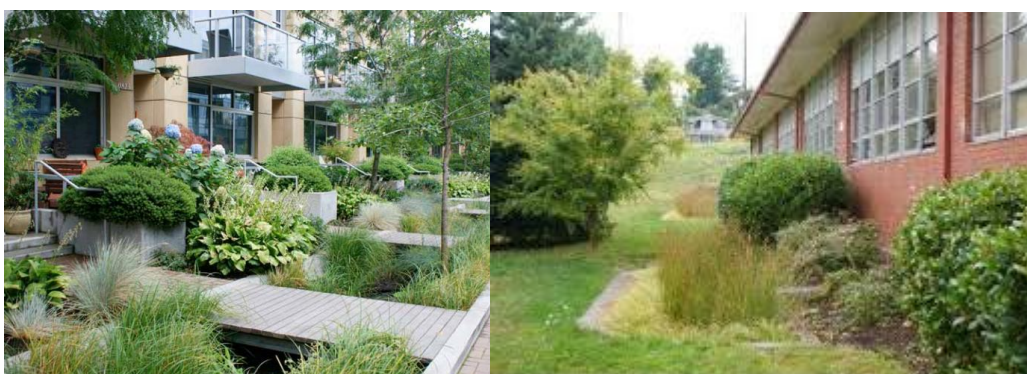
Figur 9: En mindre kanal kan avvattna och avleder vatten från kvarteretsmark. (Sweco dagvattengrupp 2017)
