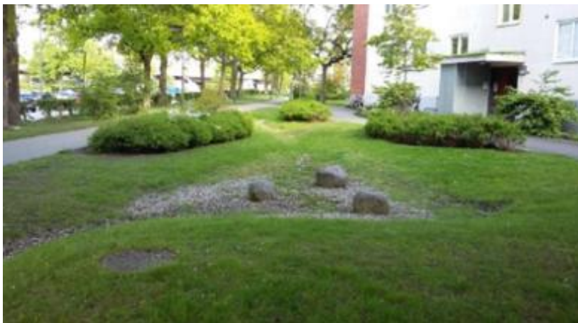
Figur 6: Torrdamm. Foto av sweco.
