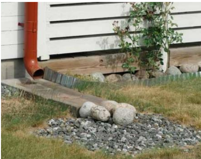
Figur 7: Stuprörutkastare och rännalsplattor med erosionsskydd som leder ut vattnet på gräsmatta. (Foto: anvisningar på dagvatten Haninge kommun)
